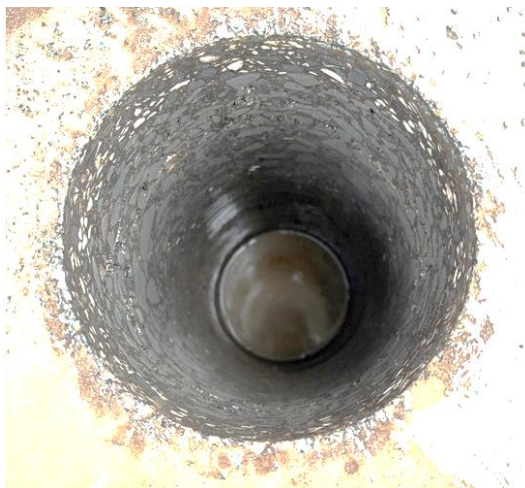
Foto des Bohrlochs
