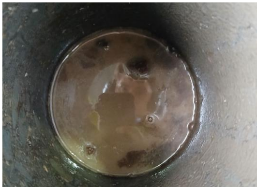
Foto des Bohrlochs
