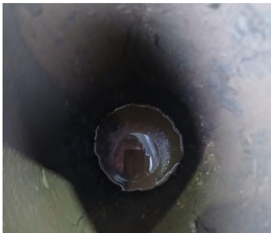
Foto des Bohrlochs
