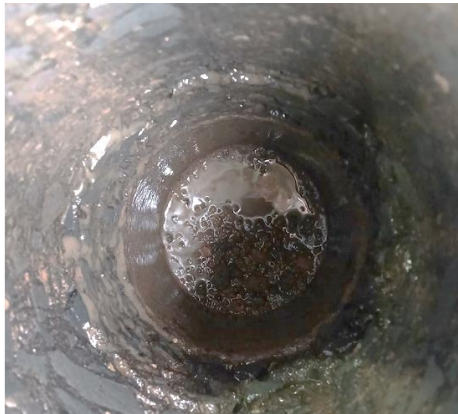
Foto des Bohrlochs
