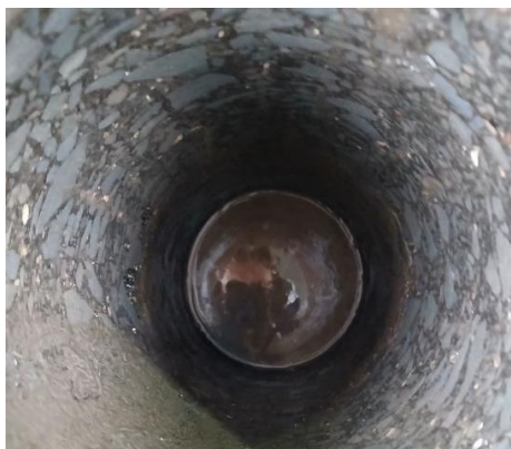
Foto des Bohrlochs
