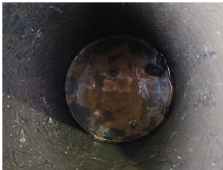
Foto des Bohrlochs
