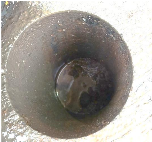
Foto des Bohrlochs
