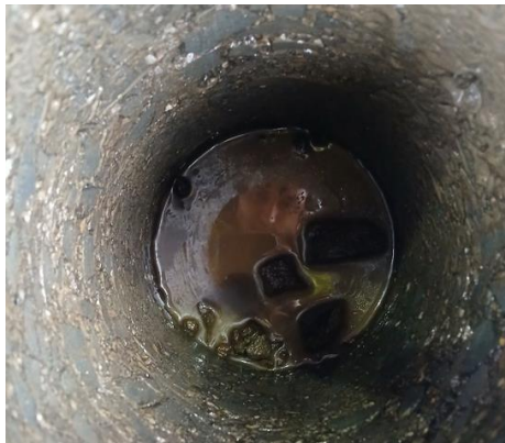
Foto des Bohrlochs
