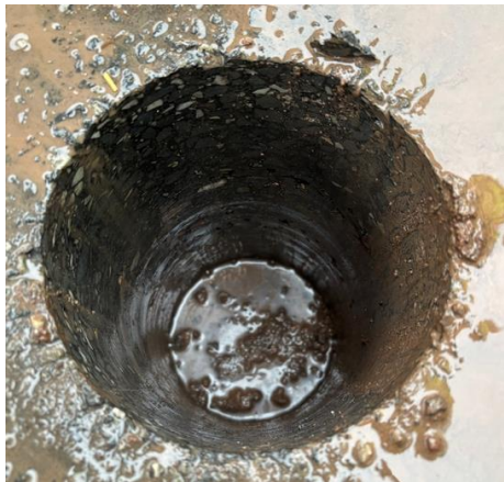
Foto des Bohrlochs
