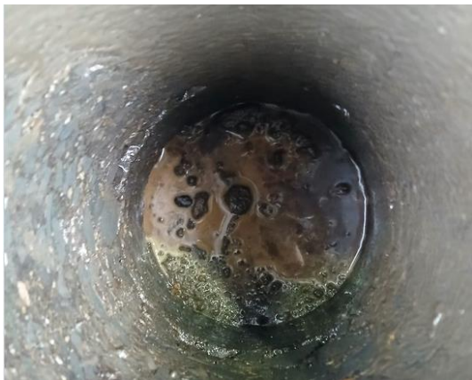
Foto des Bohrlochs
