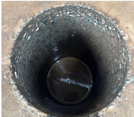
Foto des Bohrlochs
