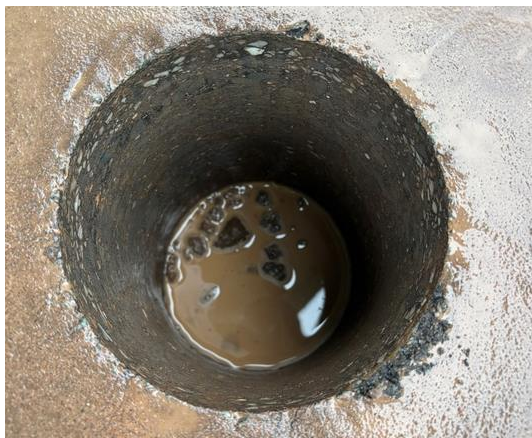
Foto des Bohrlochs
