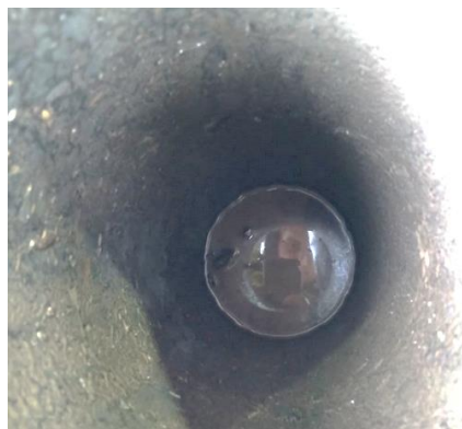
Foto des Bohrlochs
