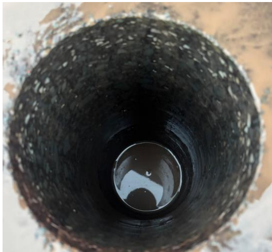
Foto des Bohrlochs
